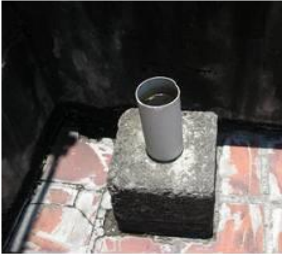
水泥樁上之水管
