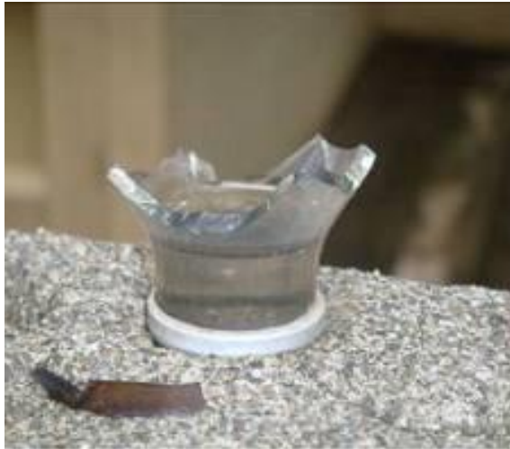
防竊盜圍牆碎玻璃
