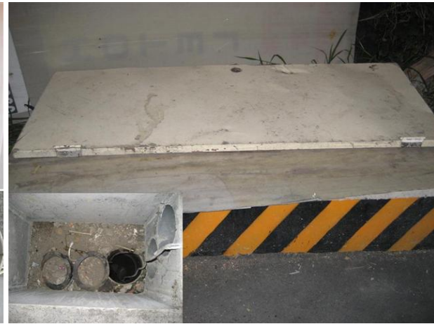
電信電纜管道
