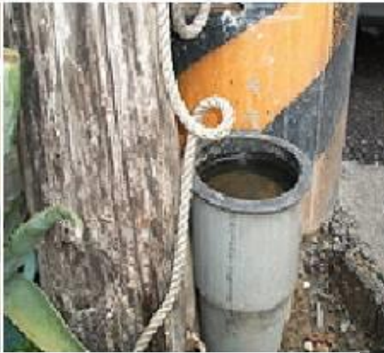
台電地下電纜引上管
