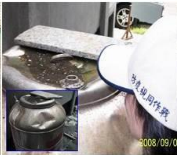
儲水桶鐵蓋凹陷處
